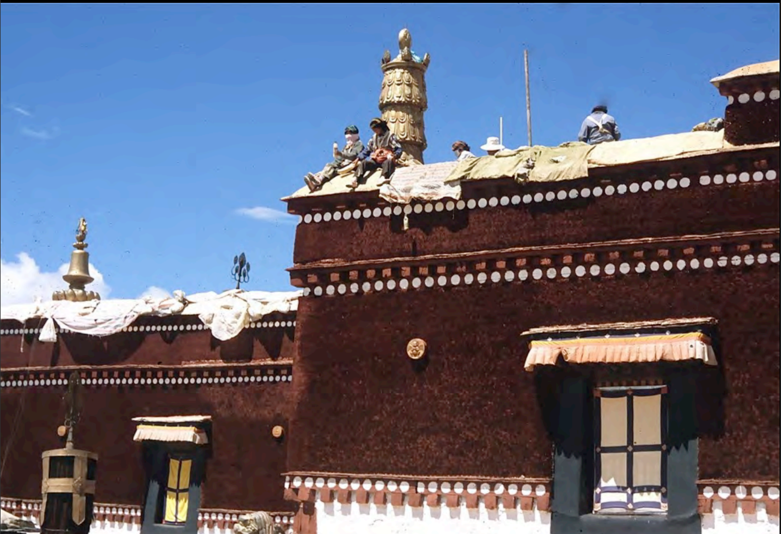
Taget er ved at blive udskiftet. Her er ingen sikkerhedsforanstaltninger eller stillads
